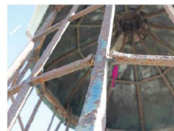
Détail de l'assemblage de la lanterne
